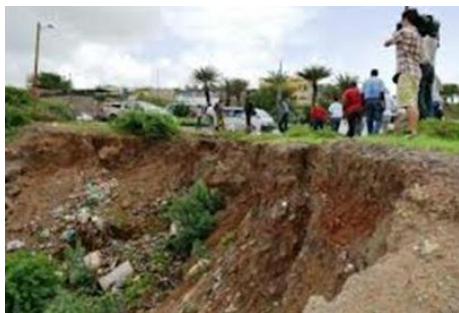
Figura 11 - Risco de derrocada de terreno na rotunda da Ponta d'Água
