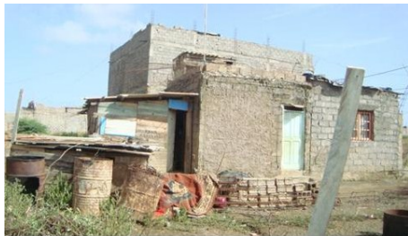
Figura 4 - Aspeto de edifício com vários cômodos em blocos de cimento e cobertura em betão armado.
