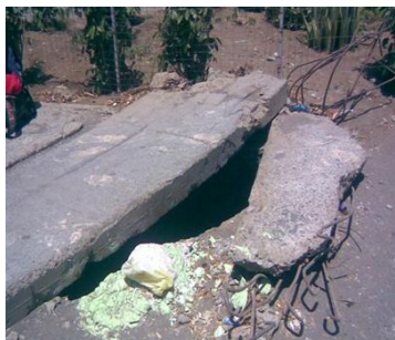
Figura 12 - Canal de drenagem com falta de manutenção.
