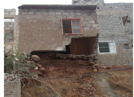
Figura 9 - Um dos riscos da construção informal, as derrocadas de terreno.
