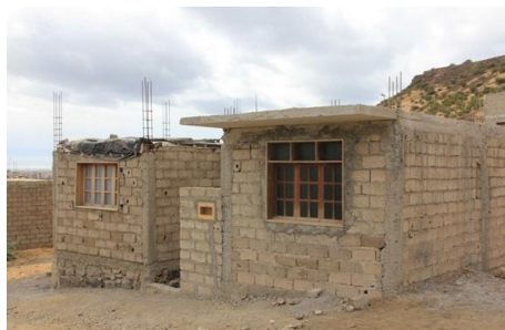
Figura 5 - Aspeto de um edifício já bastante evoluído
